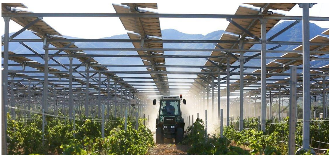
Exemple d'agrivoltaïsme, avec modules à inclinaison contrôlable
