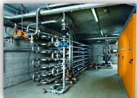
Echangeur tubulaire en sortie de STEP (Lyonnaise des Eaux, ISTINOX, ANTEA)
