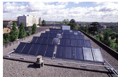
Capteurs solaires destinés à la production d'eau chaude sanitaire pour un hôtel.
