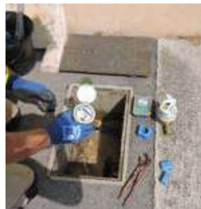
Pose d'un compteur télérelevé
