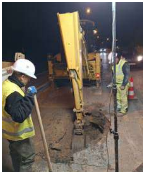
Réparation d'une fuite sur le réseau
