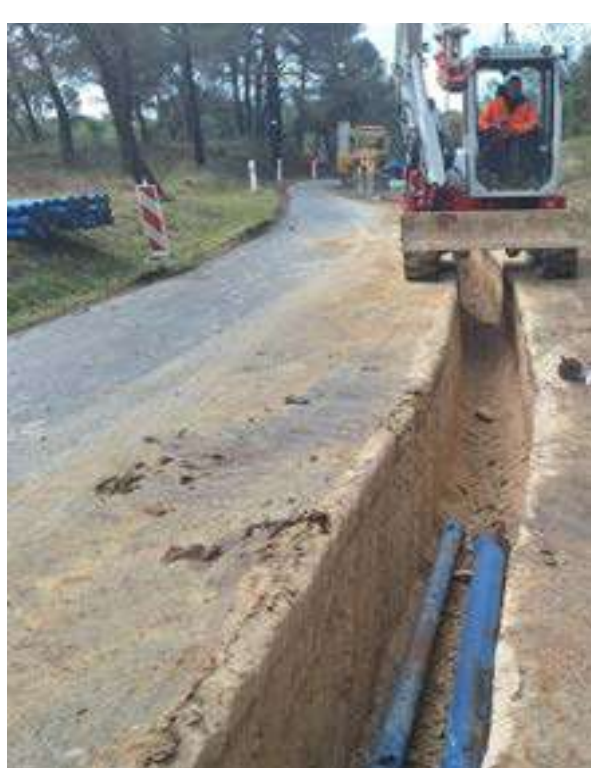
RD Route de Saint Martin de la Brasque - Commune de Peypin d'Aigues Renouvellement de 600 mètres de canalisations d'eau potable
