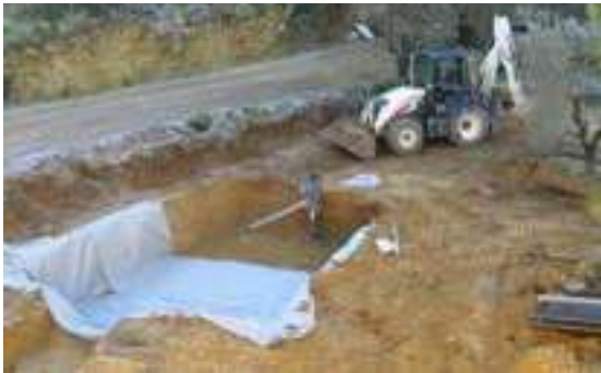
Fouille d'un filtre à sable
