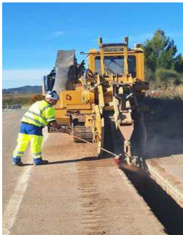
Route de Vitrolles RD 216 - Commune La Bastide des Jourdans Renouvellement de 400 mètres de canalisations d'eau potable
