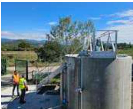
Silo à boues de la station d'épuration de Cadenet
