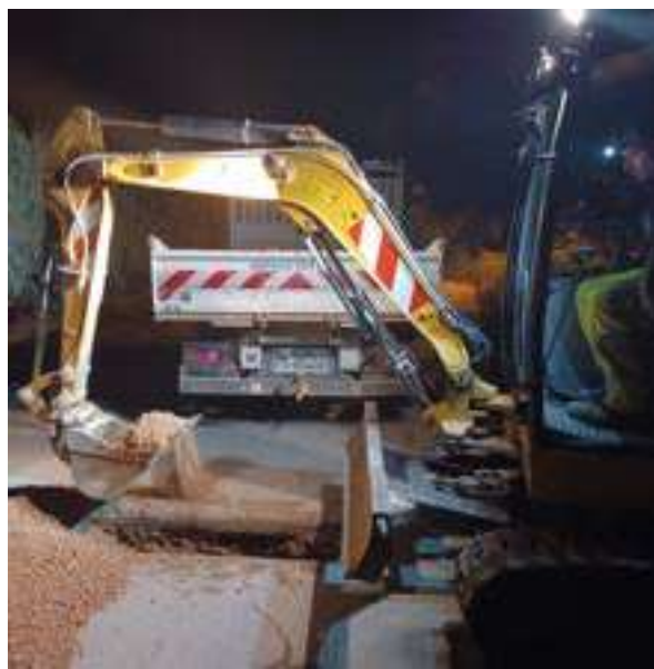
Réparation d'un branchement eau potable
