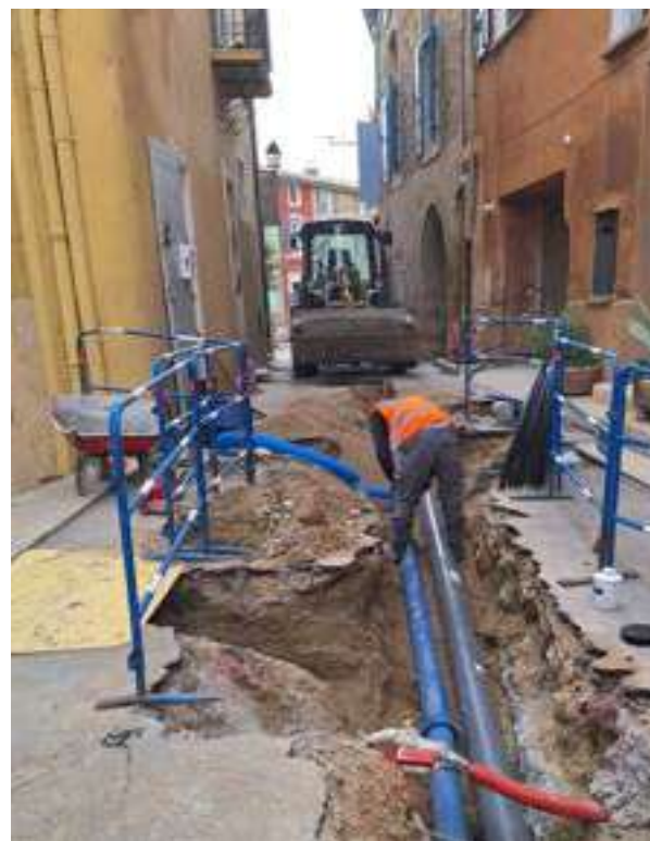
Rues Victor Hugo et Danton - Commune de Cadenet Renouvellement de 240 mètres de canalisations d'eau potable
