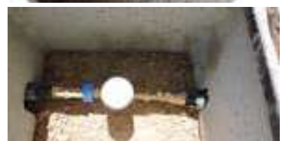
Reprise d'un branchement en plomb
