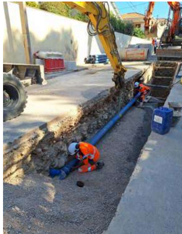
Avenue Maréchal Leclerc - Commune de Pertuis Renouvellement de 430 mètres de canalisations d'eau potable
