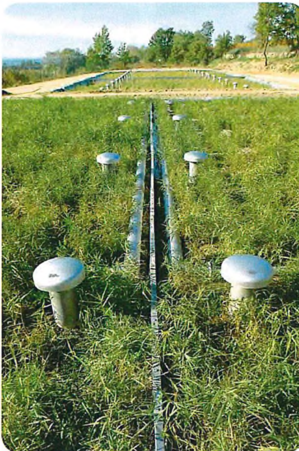
Station d'épuration biologique - Vaugines.
