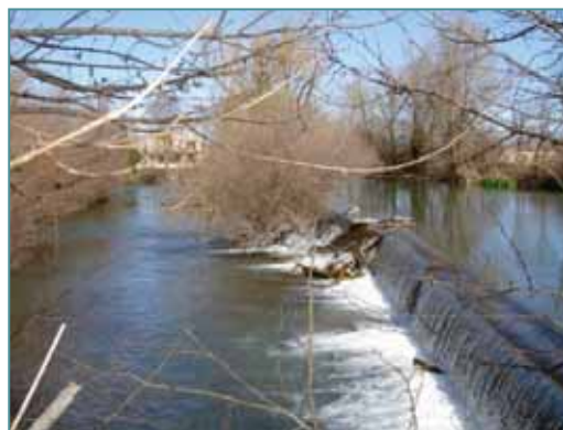
Le seuil du Moulin Vieux avant travaux
