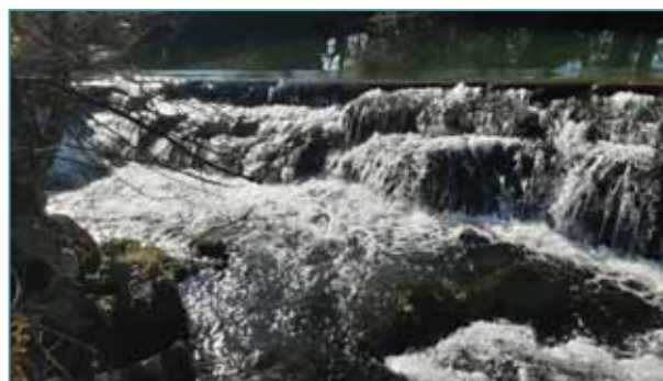
L'amont du seuil du Moulin des Toiles avant travaux (emplacement de la future passe à poissons)
