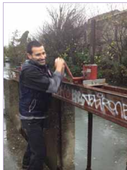
Manœuvre manuelle des vannes d'Air Liquide - Vedène
