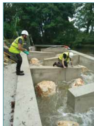
Vérification de la fonctionnalité de la passe à poissons créée
