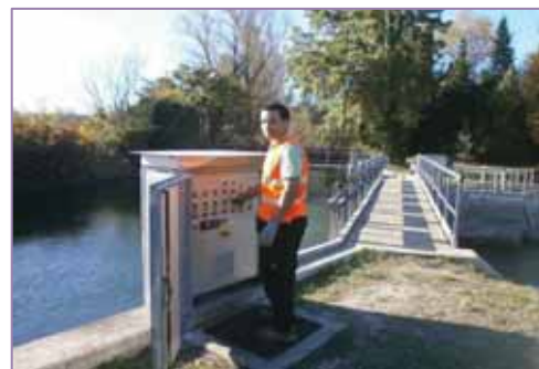
Manipulation ouvrage des Sept Espassiers
