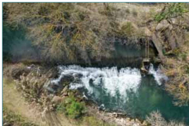
Le seuil du St Albergaty avant travaux
