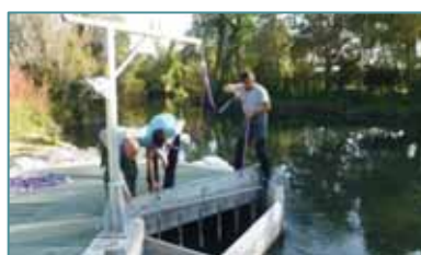
Mise à sec annuelle de la passe à poissons de la Croupière pour contrôle exhaustif
