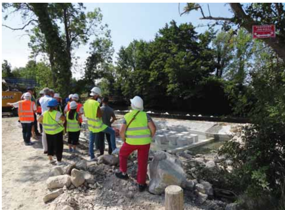
Visite de chantiers de passes à poissons (ici sur le site du Moulin des Toiles) par les élus du Comité syndical (août 2021)
