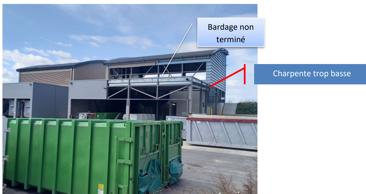
Fig. 5 – Quai de transfert du grenouillet – Bâtiment collecte sélective
