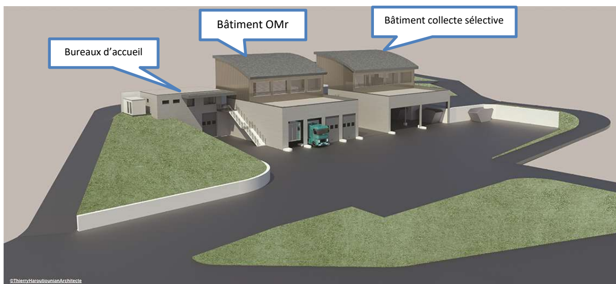
Fig. 3 – Vue du quai de transfert des déchets du Grenouillet
