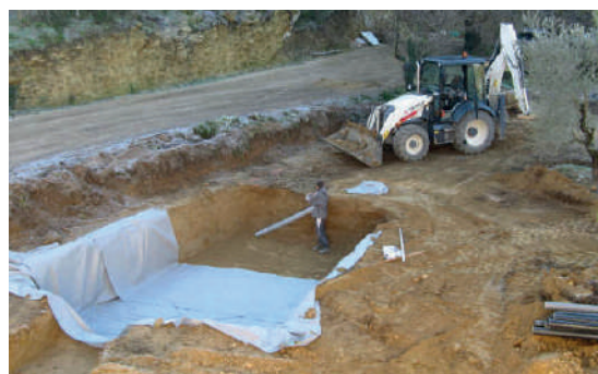
Fouille d'un filtre à sable
