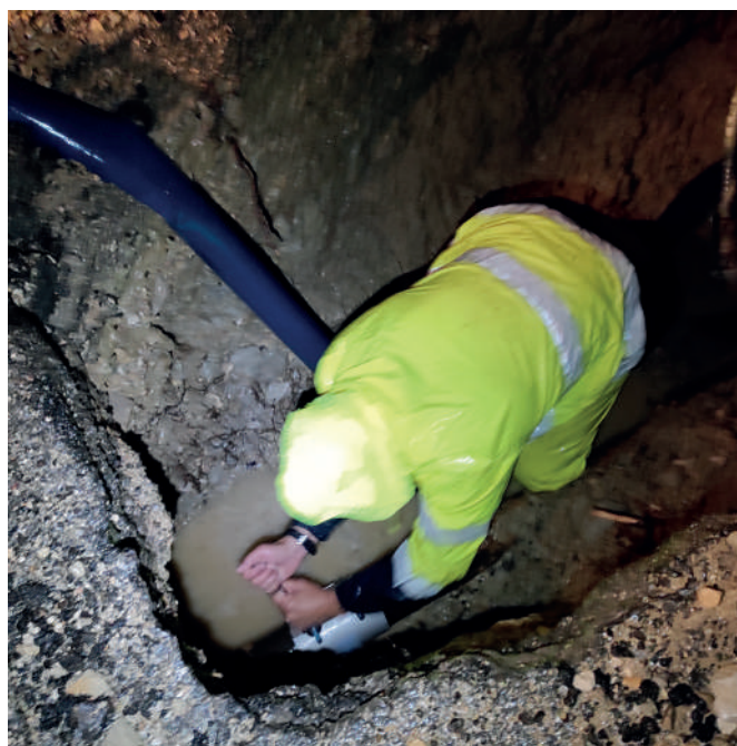
Réparation d'une fuite sur le réseau
