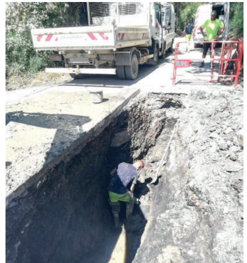
Août 2022 : intervention importante sur une fuite située sur un réseau principal
