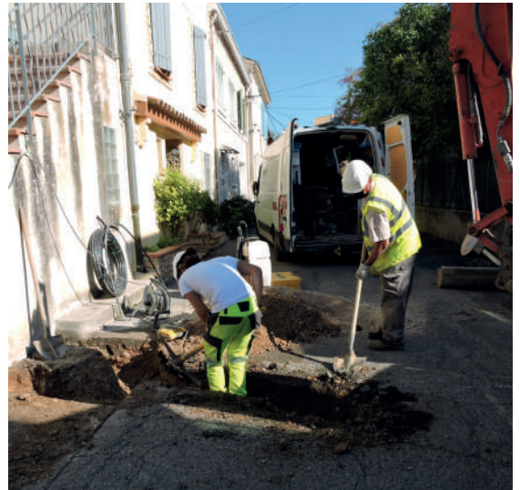
Renouvellement d'un branchement
