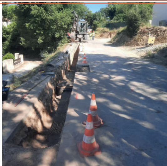
Juin 2022 : Création d'un réseau d'assainissement de collecte des eaux usées - Liaison entre le Chemin Four de la Peste et l'Avenue Pierre Augier à Pertuis
