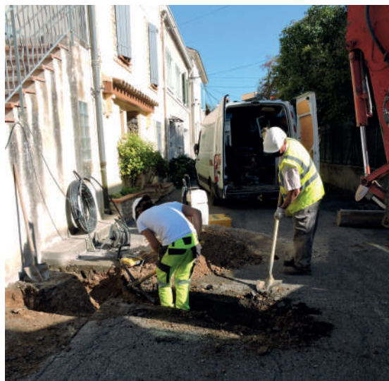
Renouvellement d'un branchement
