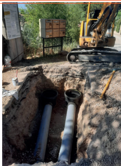
Juin 2022 : Création d'un réseau d'assainissement de collecte des eaux usées - Liaison entre le Chemin Four de la Peste et l'Avenue Pierre Augier à Pertuis
