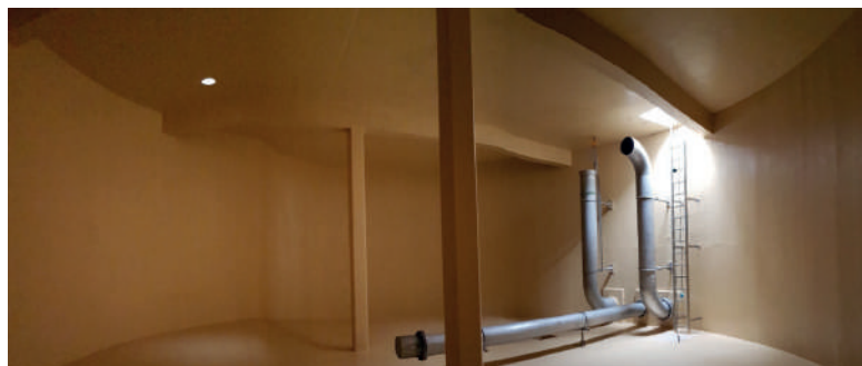
Réservoir du MotoCross à Pertuis
