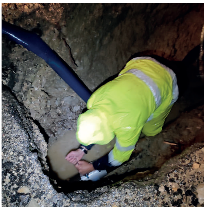
Réparation d'une fuite sur le réseau
