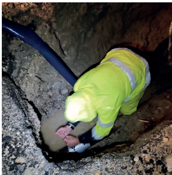
Réparation d'une fuite sur le réseau
